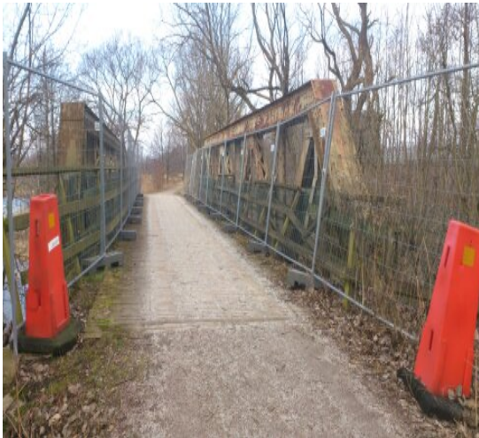
Trasig och farlig bro och cykelväg, när repareras?
